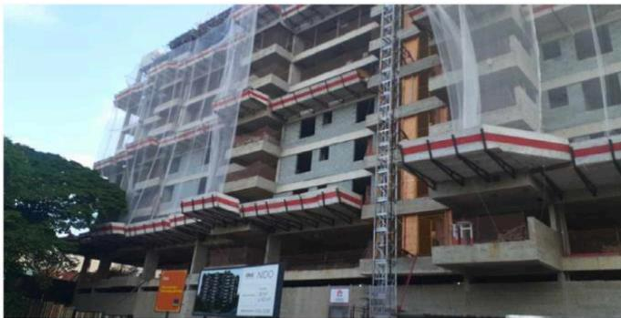
Frente da obra com elevador cremalheira já instalado e alvenaria no 3º pavimento
