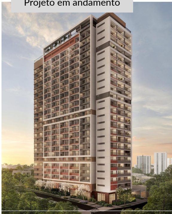
Projeto em andamento
