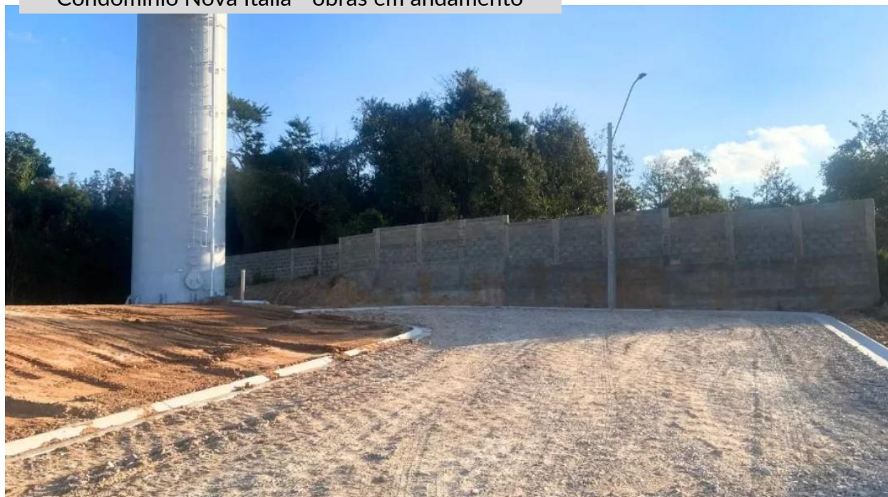
Condomínio Nova Itália - obras em andamento
