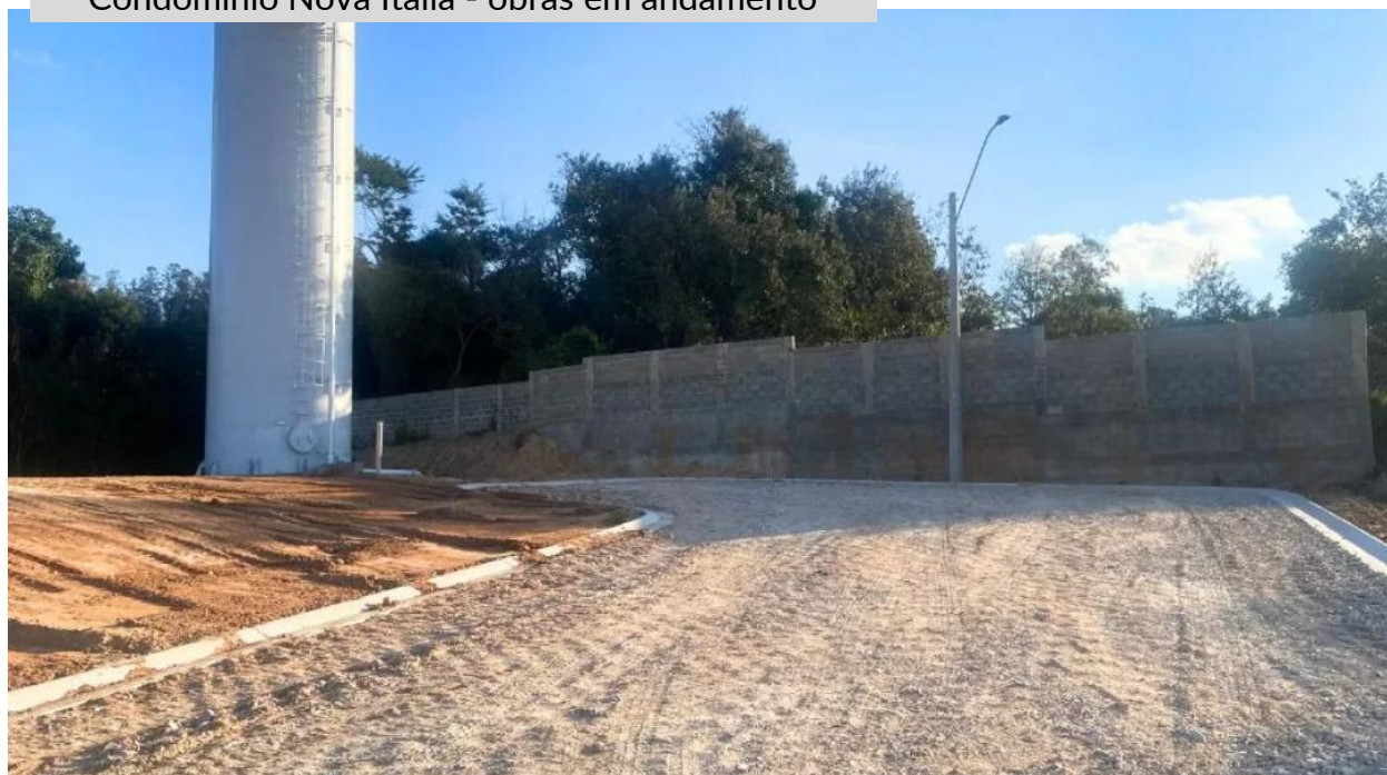
Condomínio Nova Itália - obras em andamento
